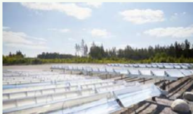
イタリアのバーリ工場における太陽熱集熱機の設置
