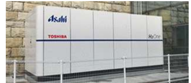
自立型水素エネルギー供給システムH 2 One™
