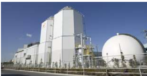
バイオエナジー(株) 城南島工場 外観
